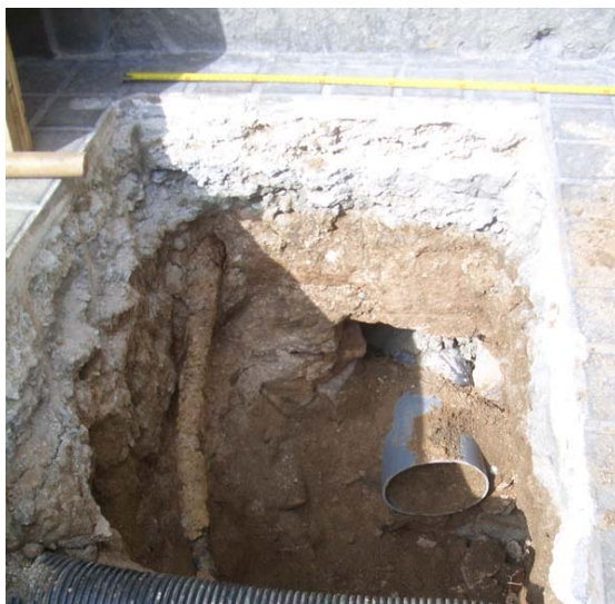
Detall de la paret NO de la rasa, amb la fonamentació de l'edifici i l'escomesa recent
