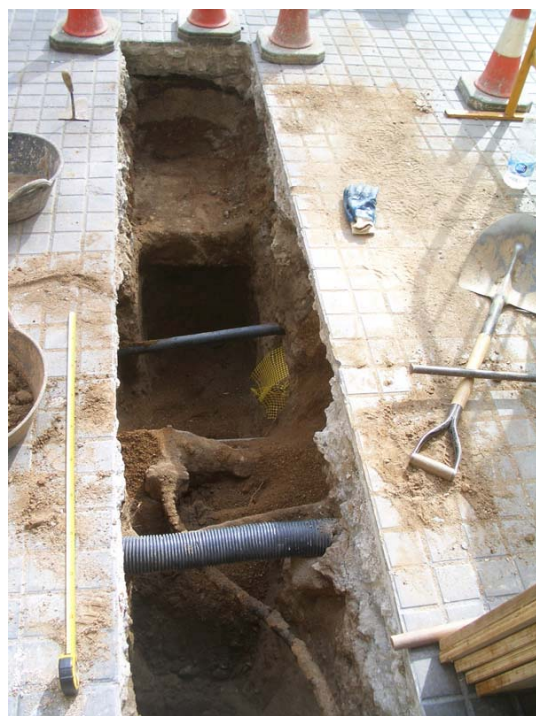
Vista SE-NO de la rasa realitzada
